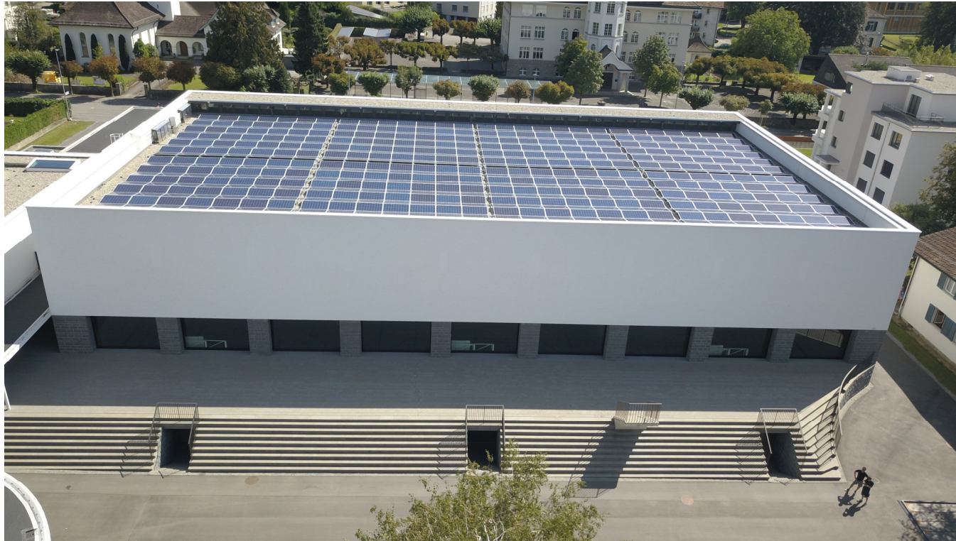
Photovoltaikanlage auf dem Dach der Turnhallen Hagen
