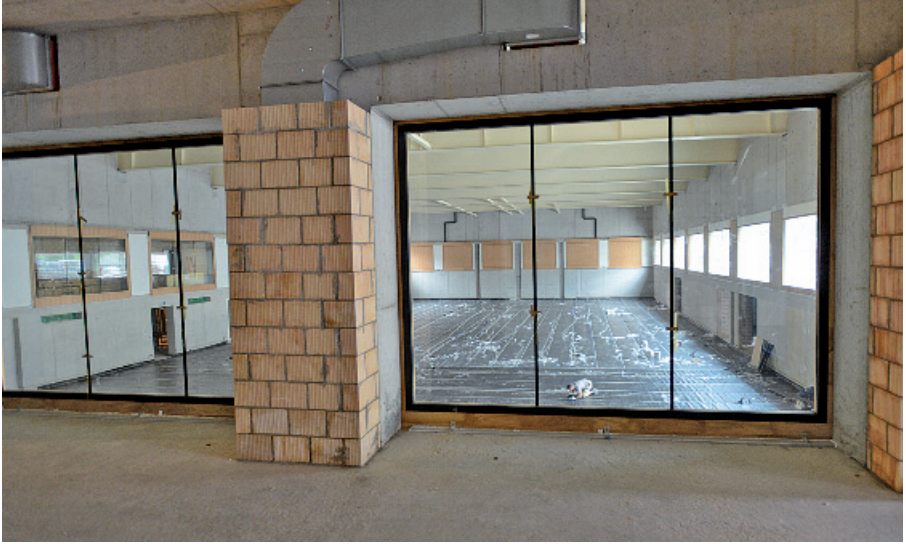
Die Fensterfronten sind montiert: Blick vom Aula-Zugang zur Dreifachturnhalle Hagen.
