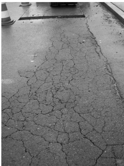
*Steinbett unter dem Belag, fehlender Koffer (Bild links) und damit eine ungenügende Tragschicht: Die Folge davon sind Risse im Belag (Bild rechts). Die Bausubstanz der Hellgasse und der Oberen Fabrikstrasse ist sehr schlecht.*
