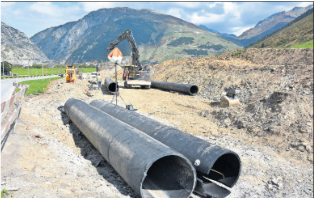
Noch bis Ende Oktober werden im Abschnitt Kreisel Andermatt bis Hospental neue Rohre für ein erweitertes System der Strassenentwässerung gelegt.
