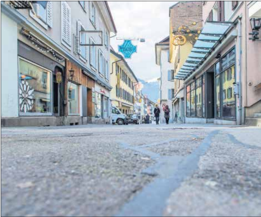
Die Schützengasse in Altdorf soll durch die Sanierung und das Verlegen von Natursteinen schöner werden. Die Bauzeit dauert bis Ende Oktober.
